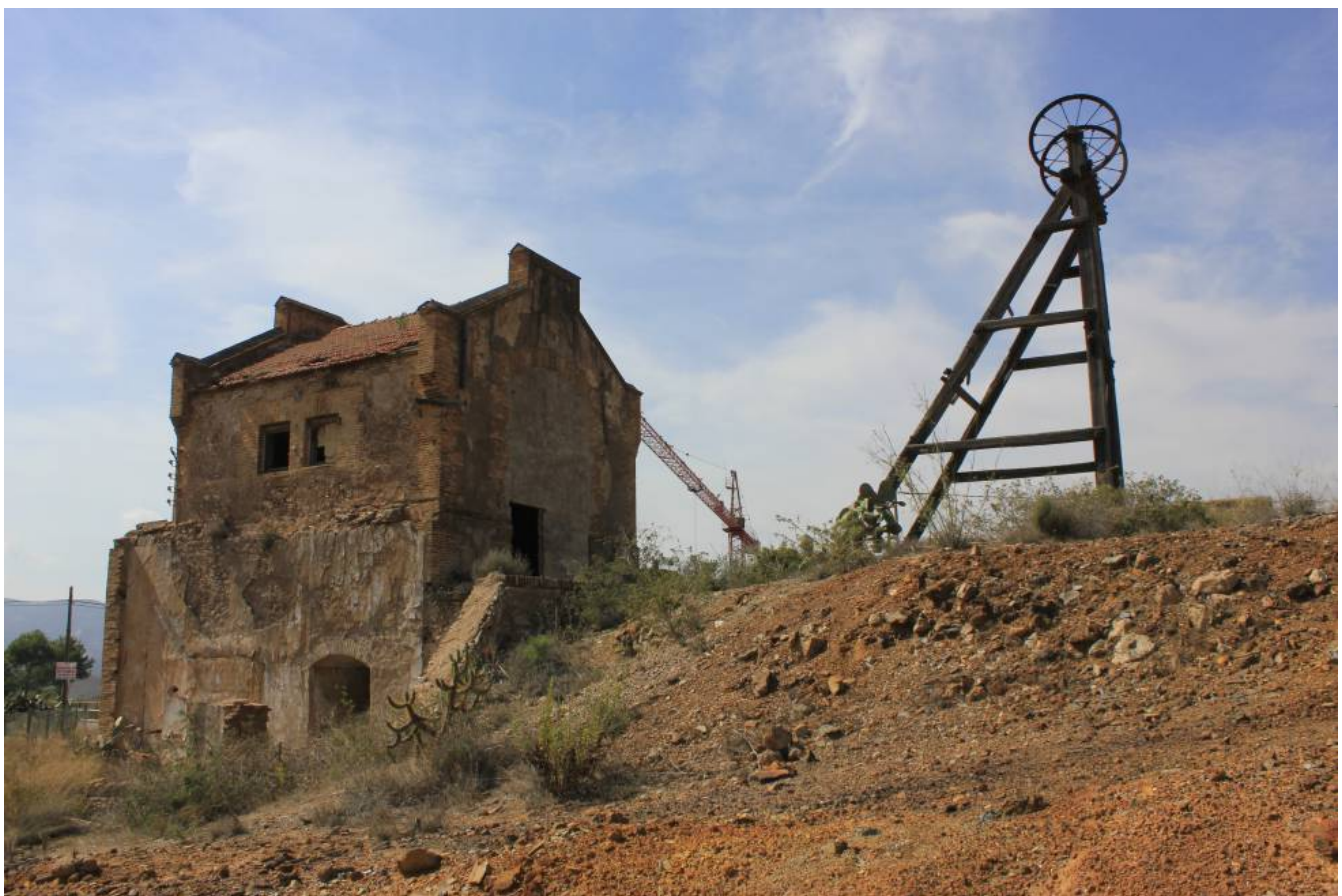
La antigua sala de máquinas y una de las cabezas de pozo en una mina abandonada cerca de La Unión, en Murcia. GETTY IMAGES
